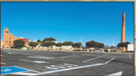
NOU APARCAMENT PÚBLIC AMB MÉS DE 100 PLACES
