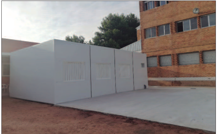
Solera de formigó al pati del col·legi públic i aula prefabricada que ocupa l'alumnat de 4 anys.
