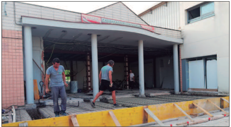
El Gimnàs Municipal en obres.
