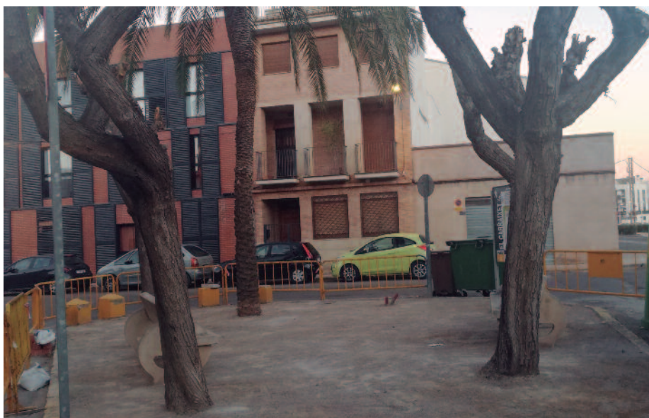
Operaris de la brigada municipal realitzen obres de remodelació a la plaça 9 d'Octubre.
