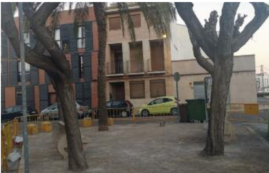
Operarios de la brigada municipal realizan obras de remodelación en la plaza 9 de Octubre.
