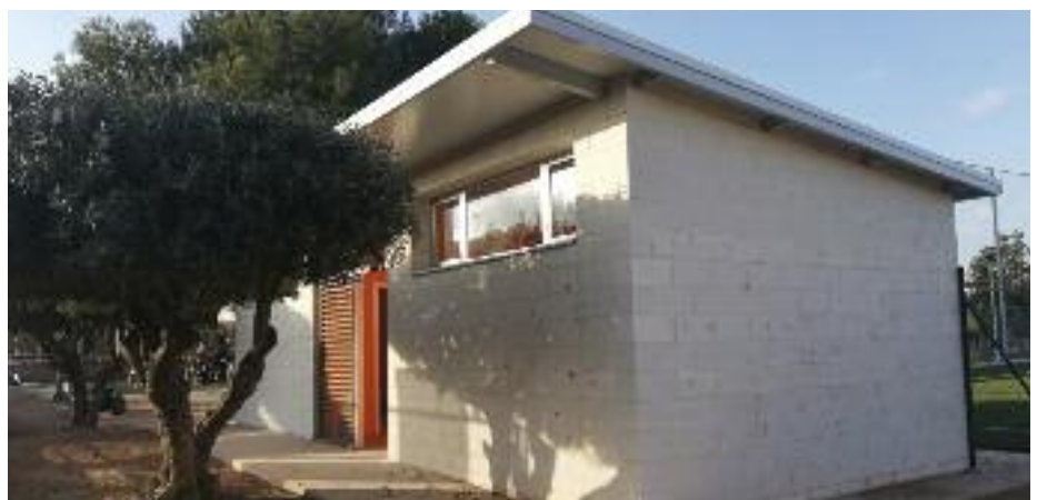
Nuevos baños públicos construidos en el polideportivo municipal.
