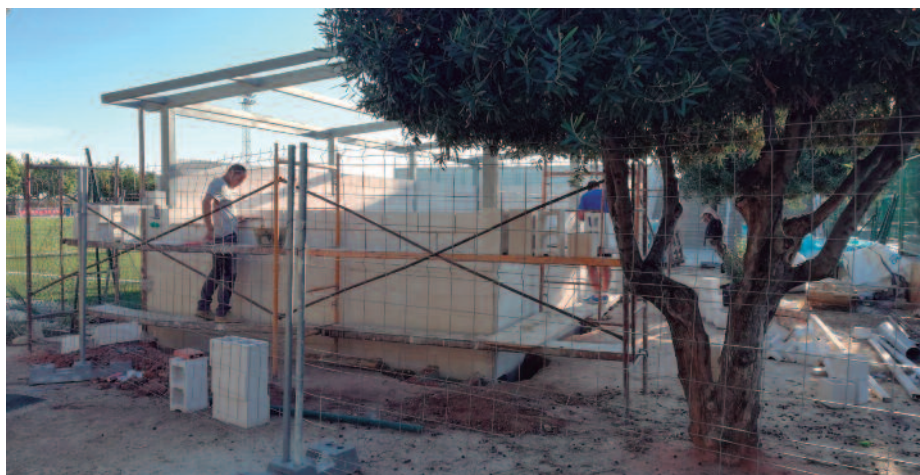
La construcció de nous banys públics en el poliesportiu ha començat.
