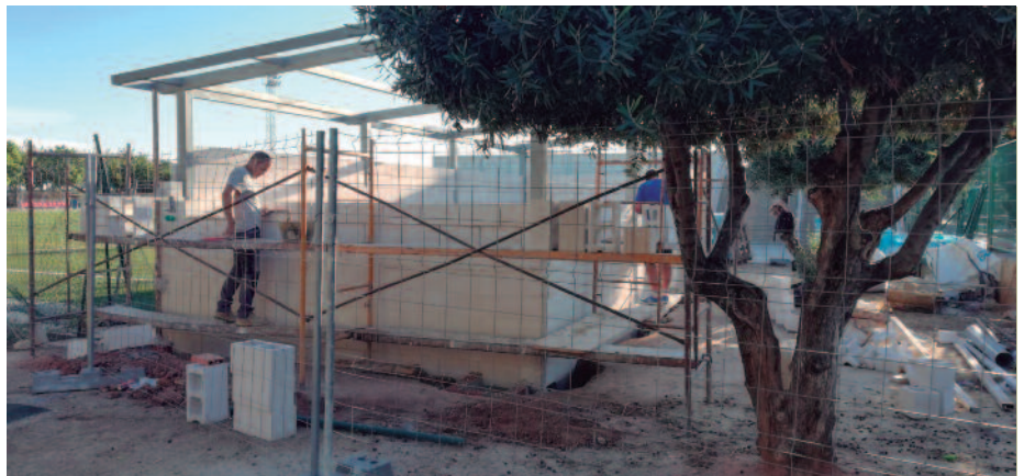
La construcción de nuevos baños públicos en el polideportivo ha empezado.
