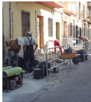
Adequació de les voreres afectades pels guals.
