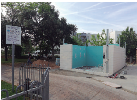
Construcció de les noves dutxes exteriors.
