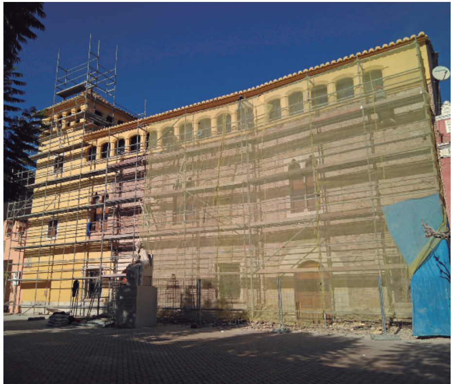
Façana principal del Castell d'Alfara, amb una gran bastida des d'on els operaris retiren el revestiment de la paret.
