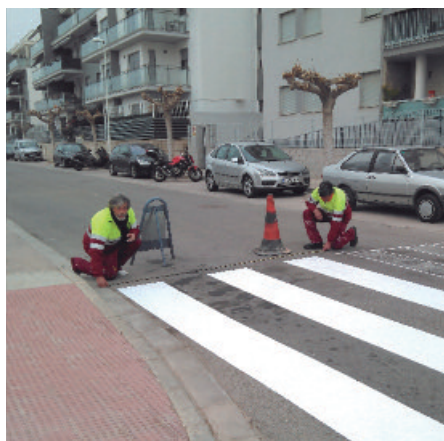
Els operaris repinten un pas de vianants.
