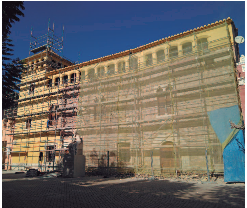
Fachada principal del Castell de Alfara, con un gran andamio desde donde los operarios retiran el revestimiento de la pared.
