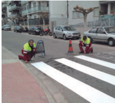
Los operarios repintan un paso de peatones.
