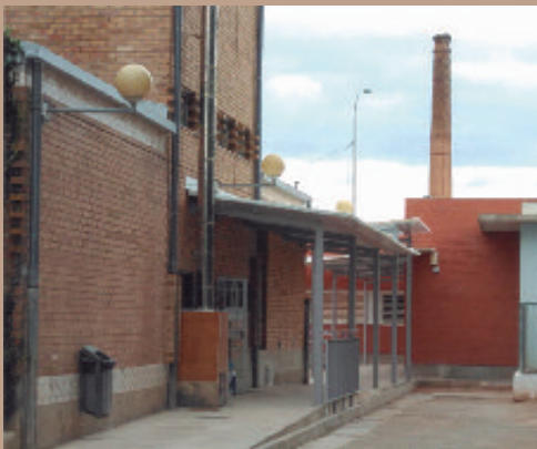
Corredor cobert que enllaça el col·legi amb el menjador.
