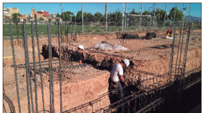
Forjat per a la correcta cimentació del futur trinquet d'Alfara.
