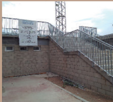
Nou accés a la graderia del camp de futbol.
