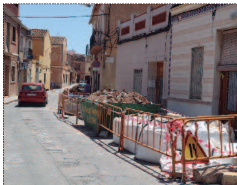
Las aceras se nivelarán con el vial, que será reasfaltado.
