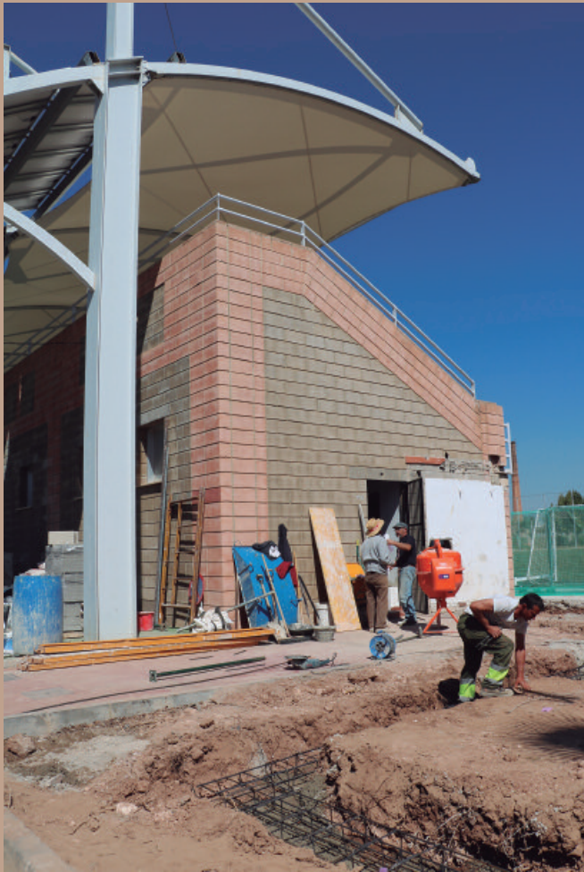
Inici de les obres de construcció d'una escala a l'altre extrem de la graderia.
