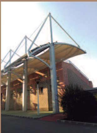
Lateral on es construirà l'eixida.
