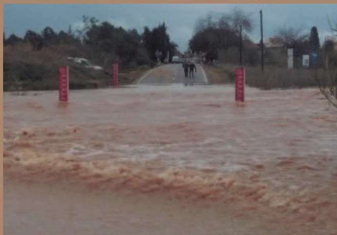
CV-304 entre Alfara i Vinalesa, submergida baix la corrent d'aigua del Carraixet.
