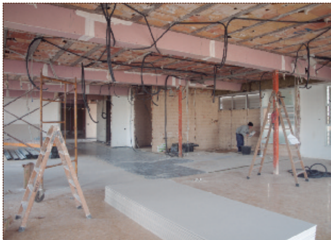
Els operaris treballen en l'adequació de l'interior de l'edifici.
