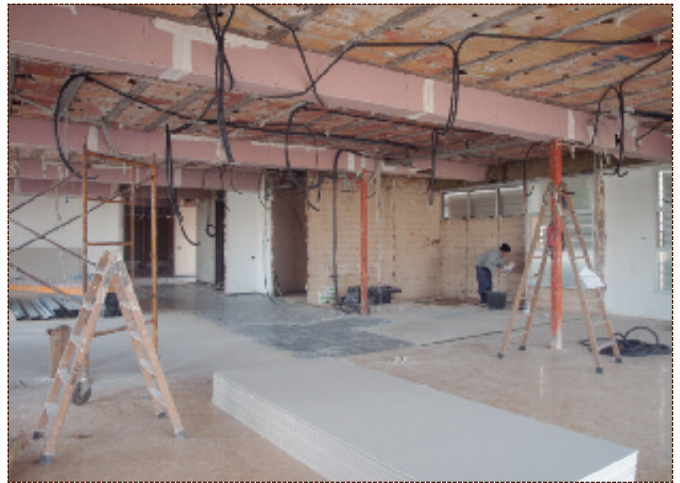
Los operarios trabajan en la adecuación del interior del edificio.
