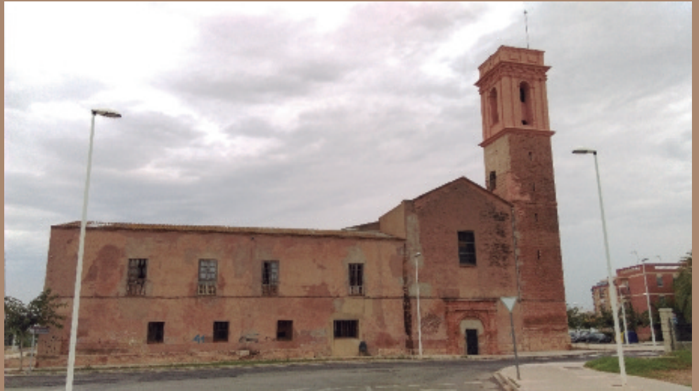
Façana principal del Convent de Sant Dídac.
