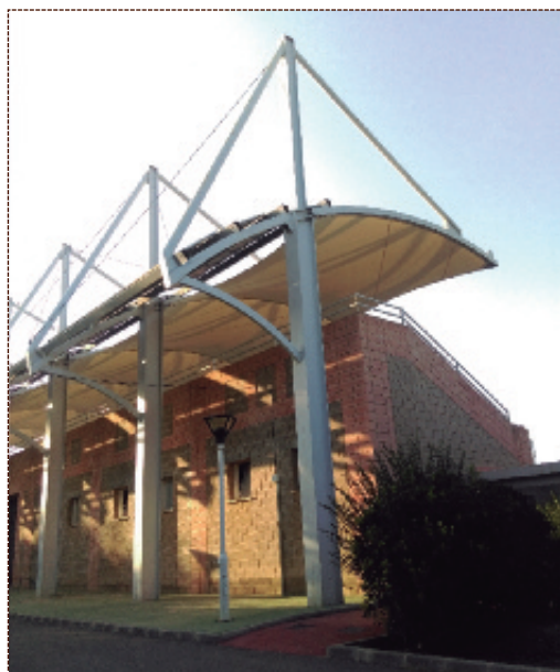
Graderia del camp de futbol del poliesportiu municipal.
